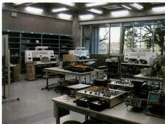
図2 電気機械実験室(14号館)
