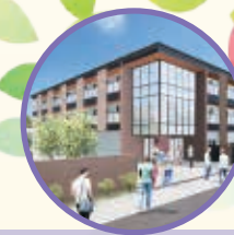
大学国際寮の建設
