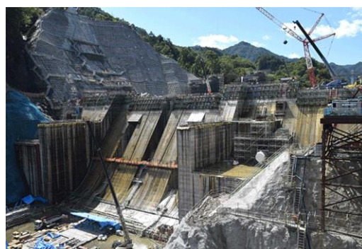
ハッ場ダム工事中
