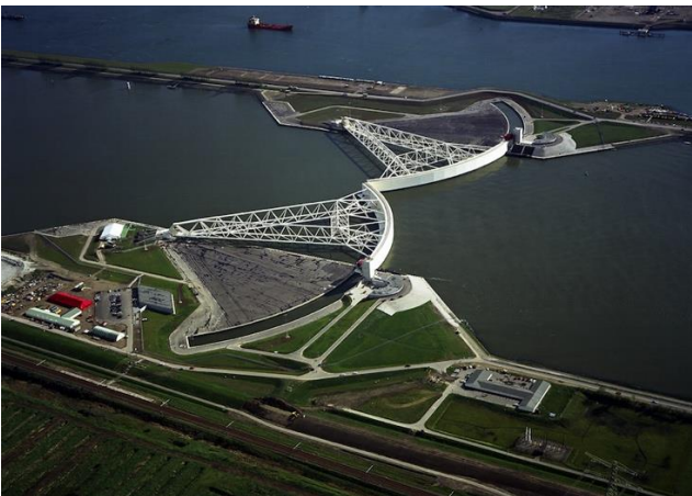
河口の巨大な防潮可動橋（堤）
