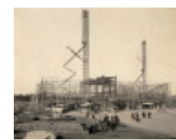
学園本館工事の様子
