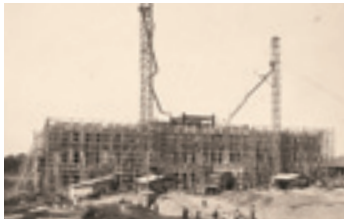
建築中の本館
