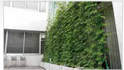
1号館西側壁面ゴーヤカーテン
