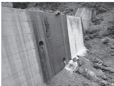
図4 砂防ダムを下流から 見たところ
