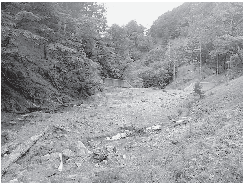
図7 砂防ダムを上流から見たところ
