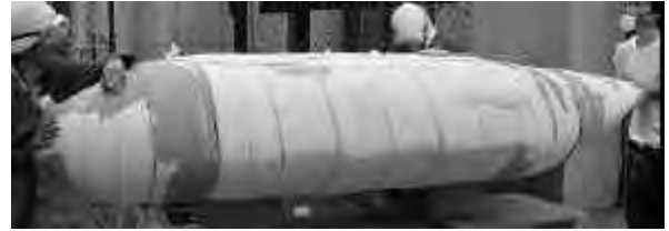
図2 従来法によるオス型の製作
