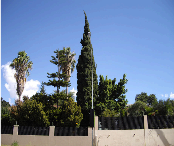
図 10 木に隠れた携帯電話基地局のアンテナ
