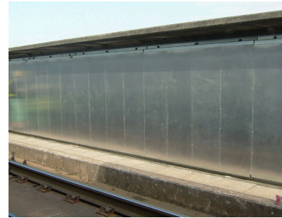
写真2. 軌道防音壁内面に設置された吸音パネル (2)
